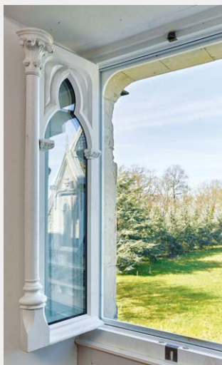
Reproduction à l'identique d'une menuiserie cintrée en élévation - forme ogive
