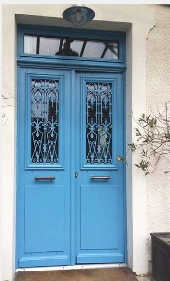
Porte d'entrée Porte fermière Restauration de grille
